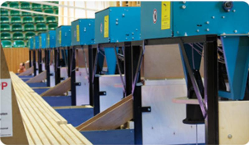
Moderner Kugelfangbereich mit entsprechenden Automatenträgern
